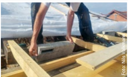
Einbau von Mauerseglerkästen
