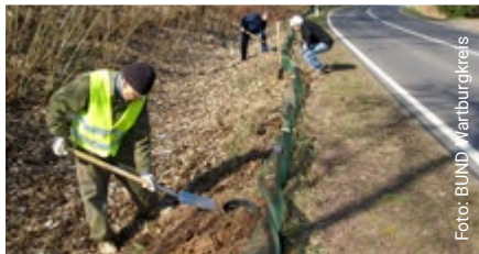
Aufbau eines Amphibienschutzzaunes an der B88
